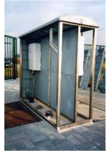
Referenzobjekt: Glasfaser-/Übernahme-Verteilerpunkt (HLKomm/MITGAS)
